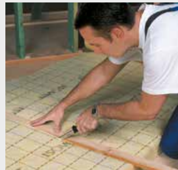
Fig. 2 Snij de gewenste breedte langs de maatstrepen af met een lat en het ISOVER isolatiemes.
